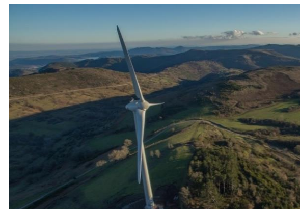
Parc éolien de BERNAGUES – LUNAS (34) Mis en service en 2016
