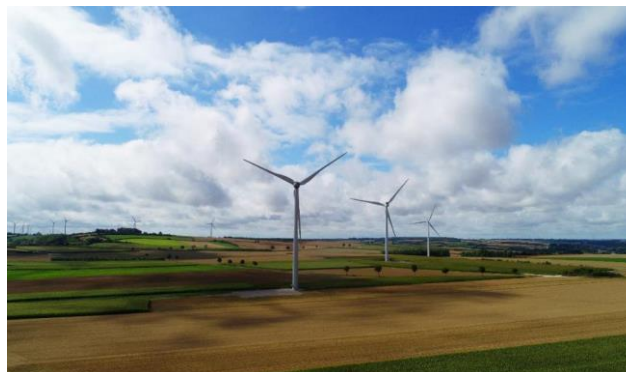
Parc éolien d'Audinctun (62) Mis en service en 2019
